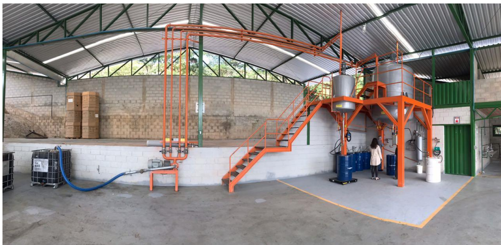
Figura 14 – Adequações físicas na planta da indústria com recursos próprios, instalação de agitadores com motor a prova de explosão e adequação da área de armazenagem (Etapa 1 do PBH).
