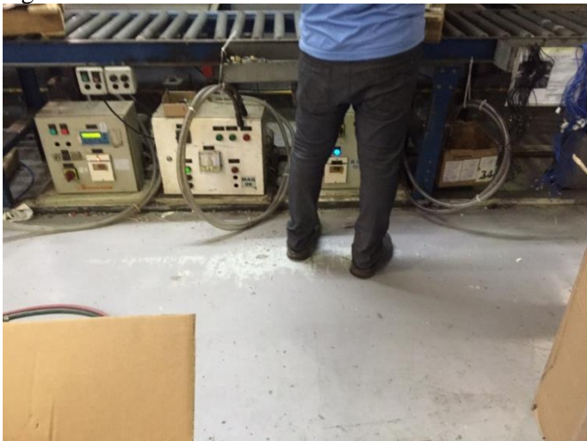
Figura 2: Bombas de vácuo
