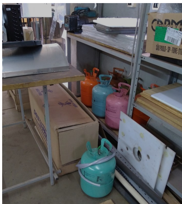
Figura 2.8 Área de carga e de estocagem de fluidos refrigerantes.
